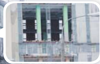
◀ Уже к лету новочебоксарцы и гости города увидят обновленный яркий фасад. На данный момент здание стоит без стеновых панелей с одной из сторон • Фото «Про Город»
